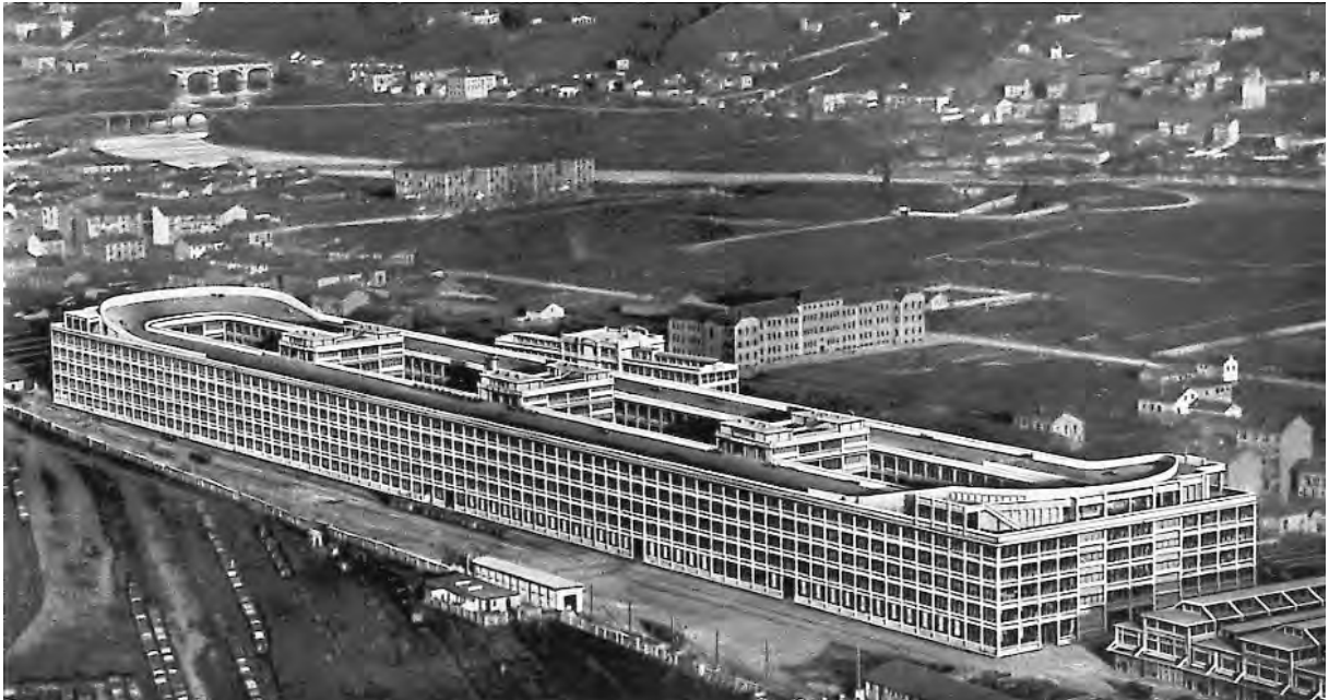
Giacomo Mattè Trucco: Fiat-Werke Lingotto bei Turin (fertiggestellt 1926).
