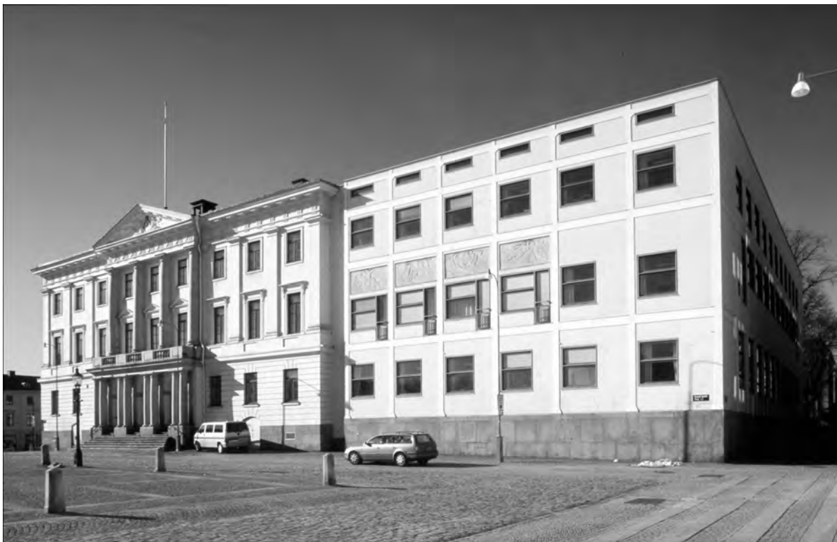
Erik Gunnar Asplund: Erweiterung und Sanierung des Rathauses in Göteborg (1913-1937).
